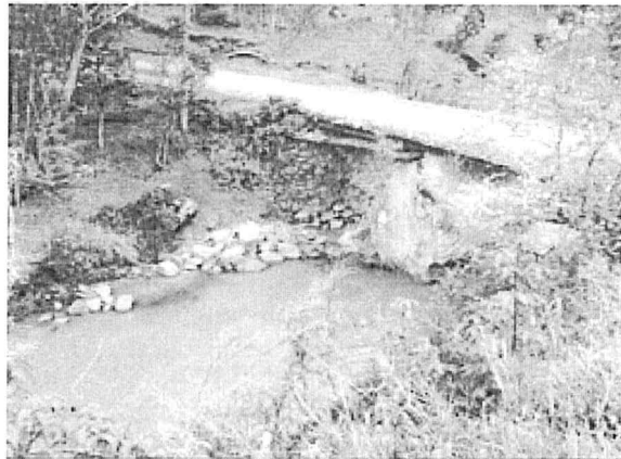
Acceso al margen derecho de puente proyectado
