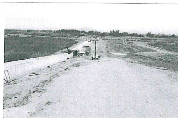
Acceso al margen izquierdo de puente proyectado.
