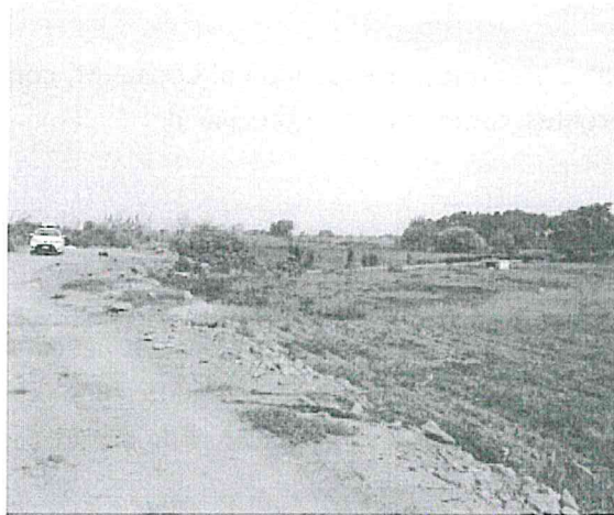
Acceso al margen iderecho de puente proyectado
