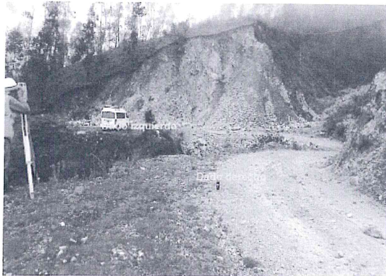
Foto 4: Condiciones de la zona de intervención adecuado
