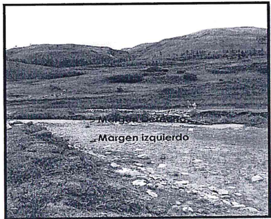
Foto N°02: Se observa manto rocoso de la superestructura
