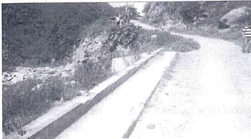
Se observa el mal estado de la superestructura, luego se haber soportado el paso de las aguas del río la cuesta en el 2017.
