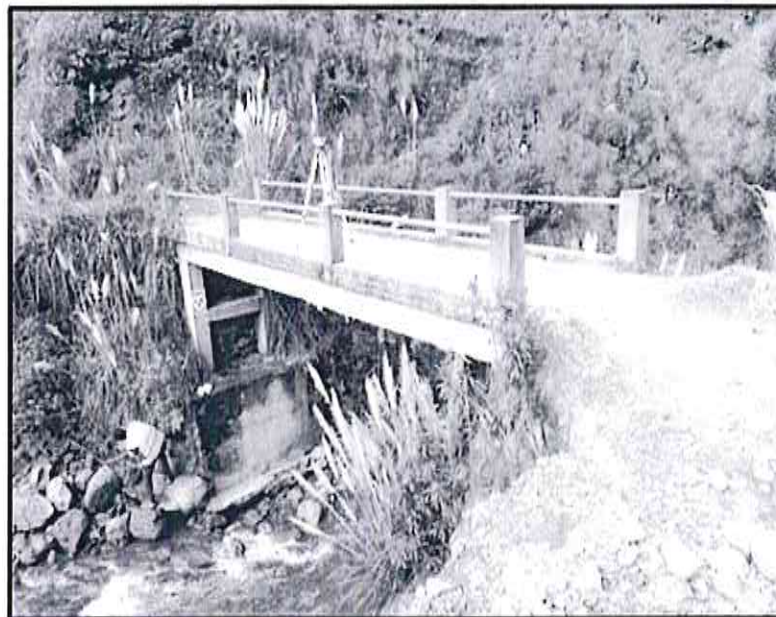
Fotografía N° 03: Vista del estado actual del puente "Palo Blanco".
