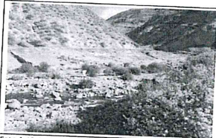
Foto 4: Vista de la ubicación de los nuevos dados del estribo el cual sera en esta explanada al costado de los terrenos de cultivo guardando distancia del lecho de río.
