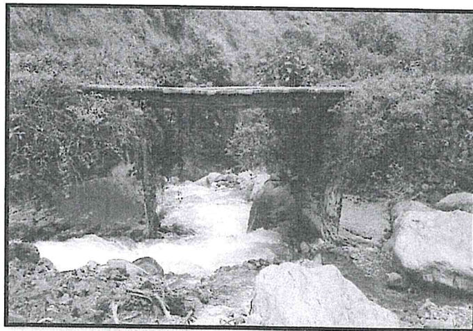
Fotografía 2 Estribos de mampostería del puente actual.
