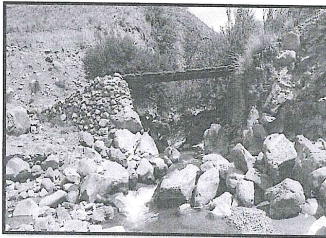
Fotografía 2 Estribos de mamposteria del puente actual.
