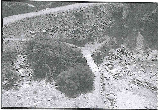
Fotografía 1 Vista del puente provisional existente
