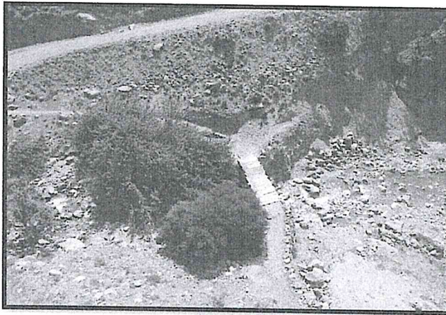
Fotografía 1 Vista del puente provisional existente
