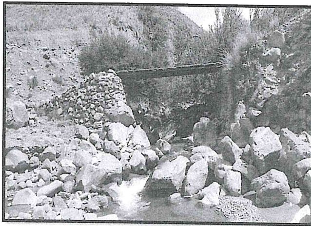
Fotografía 2 Estribos de mamposteria del puente actual.
