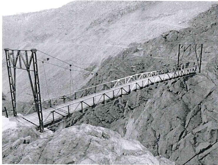
Vista Panorámica del Puente Quishuarani
