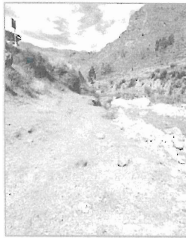
Ilustración 4: Margen Izquierdo del Río Donde se Ubicará el Estribo Izquierdo
