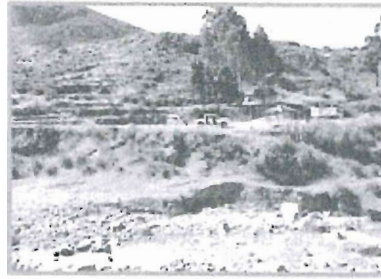
Ilustración 3: Vista Panorámica De La Zona De Instalación Del Puente
