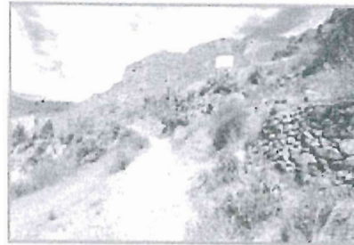
Ilustración 5: Margen Derecho del río donde se ubicará el estribo derecho
