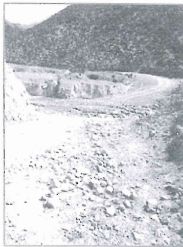
Ilustración 3: VISTA PANORÁMICA DE LA ZONA DE INSTALACION DEL PUENTE
