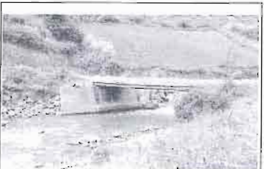
Foto 6: Vista de los elementos o estructura del puente, aguas abajo.
