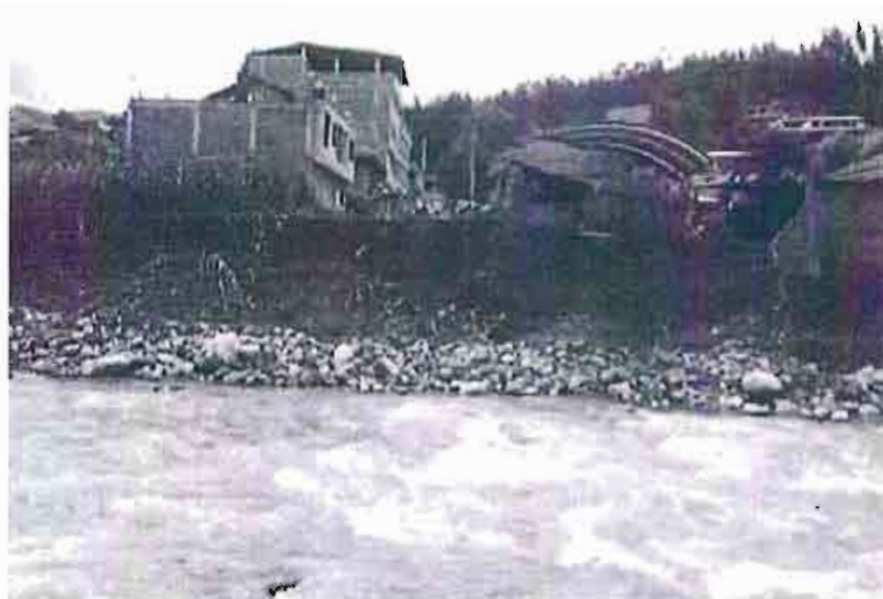
Fotog. 2. Se aprecia acceso izquierdo del en el puente Puma
