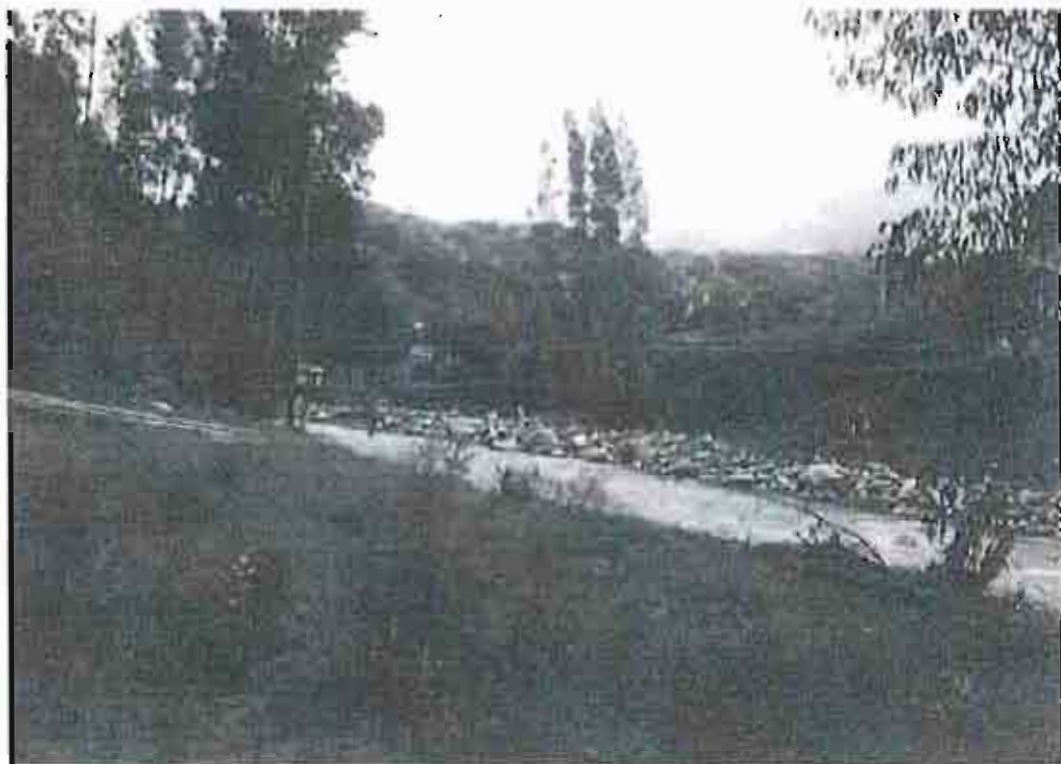
Fotog. 1. Se aprecia la línea donde se instalará el puente ya que el puente actual no existe, Colapsó.
