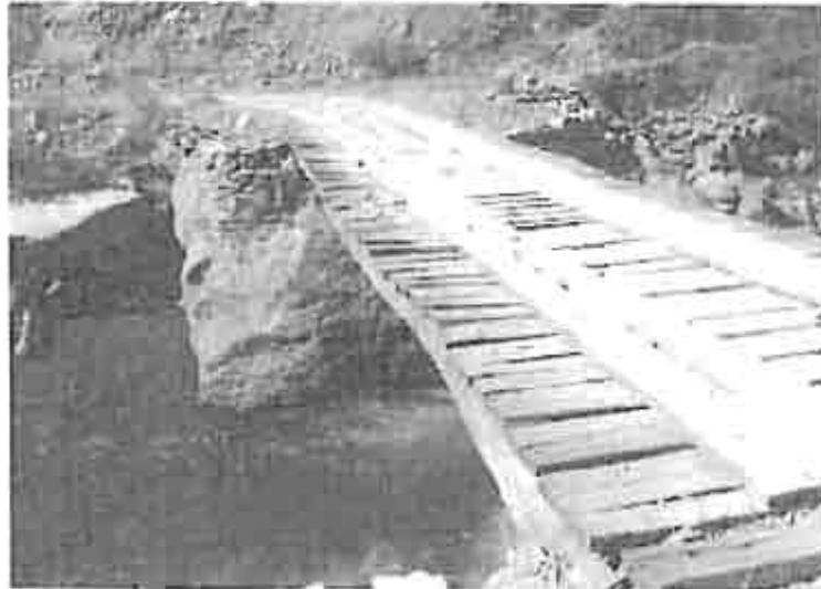
Tablero existente de Madera en malas condiciones de 10,45 x 3,30 mts
