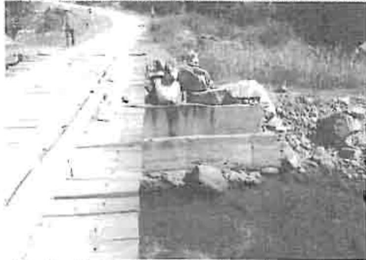
Vista del estribo de concreto, ya con problemas de socavación local
