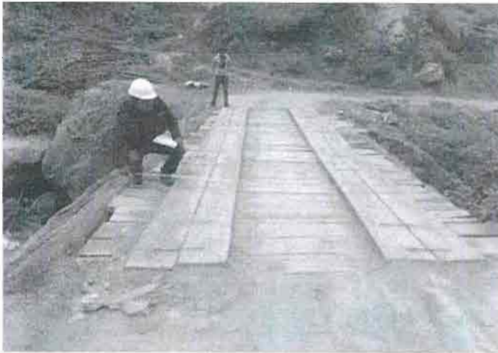
Fotog. 02: Puente Chacchan, se observa las maderas del tablero del puente
