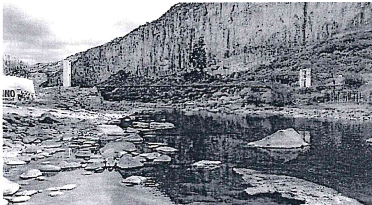
Vista Panorámica del Puente Sondondo
