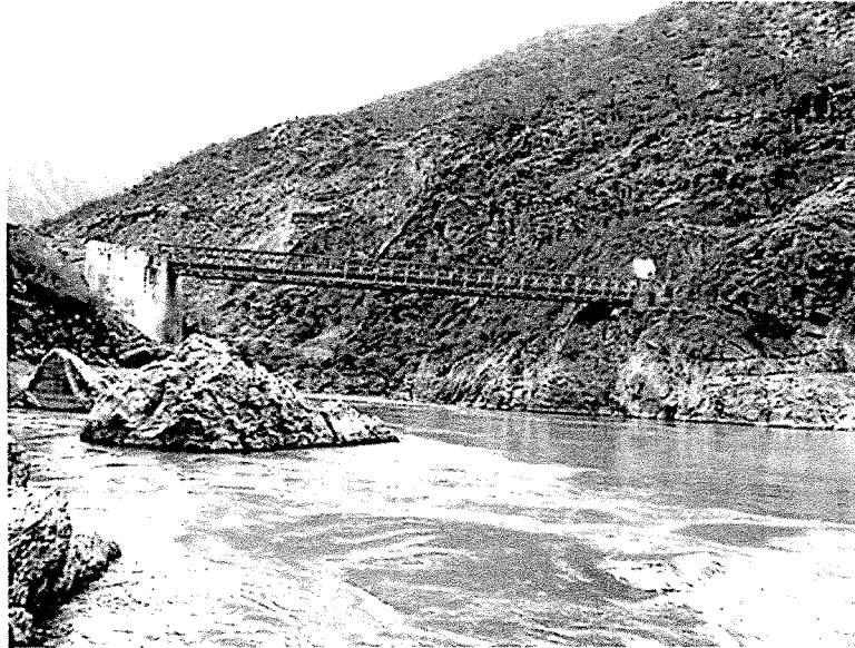
Vista Panorámica del Puente Chiquiac
