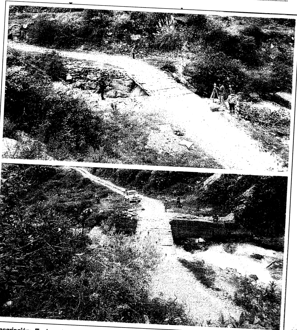
Descripción: En las vistas se aprecia el puente existente con sus accesos y el río aguas arriba y aguas abajo. Nótese el caudal del río en el mes de mayo 2019 (temporada de avenidas), y la estructura existente del puente.
