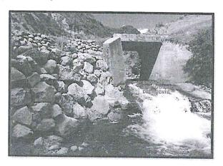
La superestructura se encuentra en condiciones regulares, pero esta se podría ver afectada debido al desgaste de la superficie a consecuencia de cargas originadas por los diferentes vehículos que transitan por esta zona.
