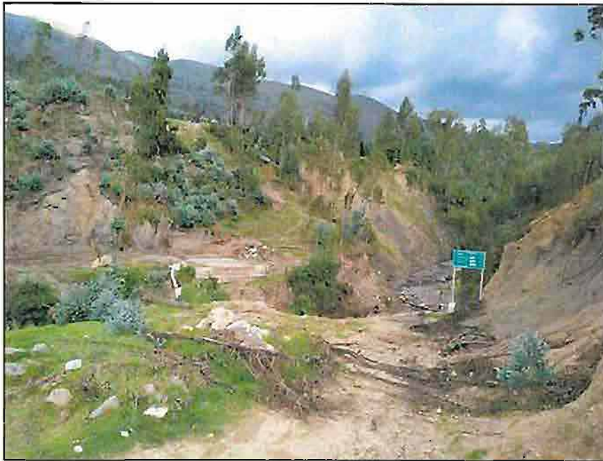
FOROGRAFIA 01: Vista del estado actual del puente zona no elegible FUETE: Expediente Técnico
