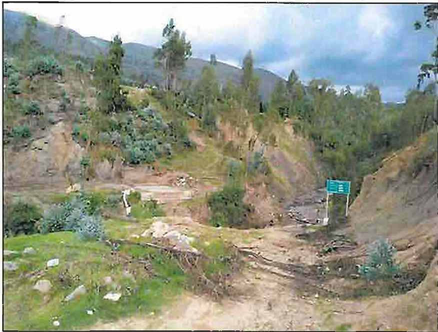
FOROGRAFIA 01: Vista del estado actual del puente zona no elegible FUETE: Expediente Técnico
