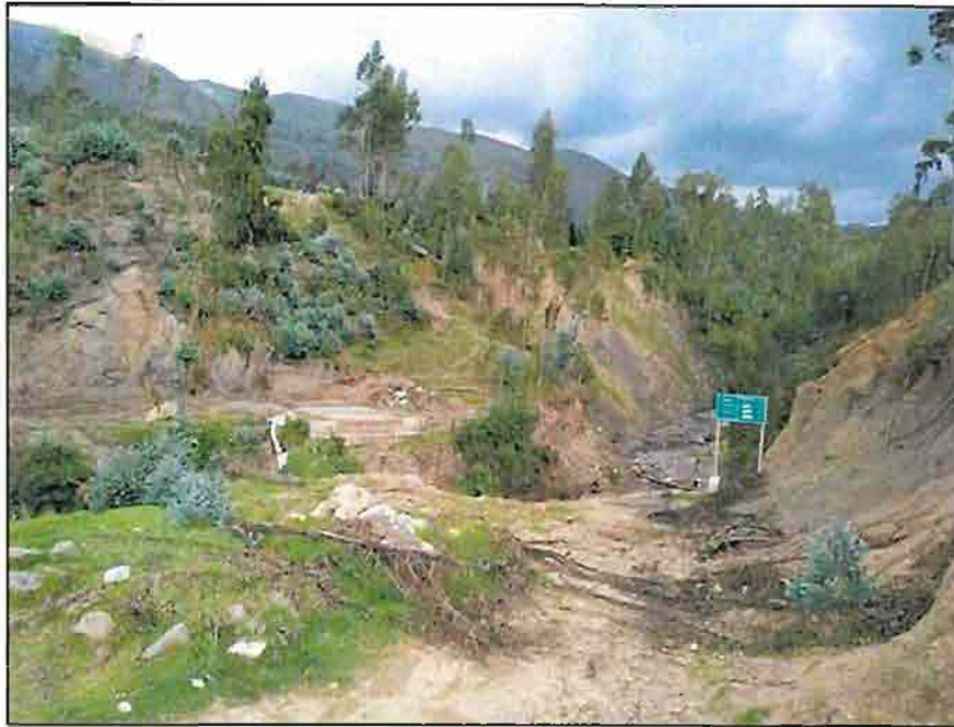
FOROGRAFIA 01: Vista del estado actual del puente zona no elegible
